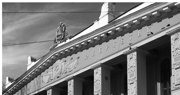
Рис. 4. Конструкция фронтона фасада главного корпуса санатория «Энергетик». 2018 год
