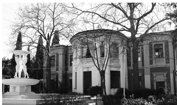
Рис. 9. Восточный фасад второго корпуса санатория «Энергетик». 2018 год
