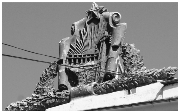
Рис. 3. Акротерий главного корпуса санатория «Энергетик». 2018 год
