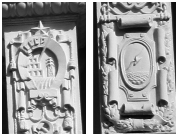
Рис. 5. Барельефные композиции на колоннах главного корпуса санатория «Энергетик». 2018 год
